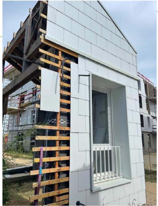
Une fois le panneau positionné (photos 1 et 2), les poteaux sont coffrés (photo 3), et le coulage est effectué (photo 4),
