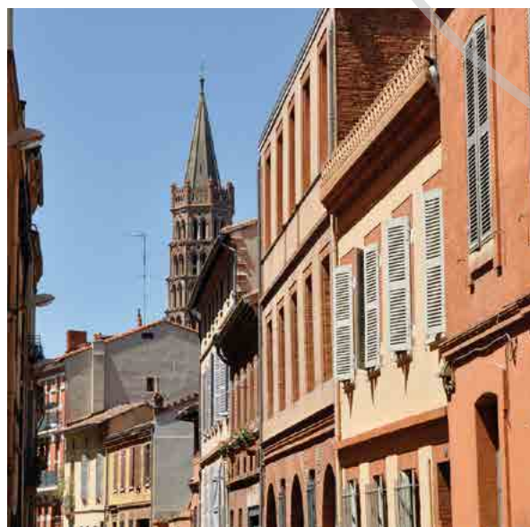
Le centre ancien
